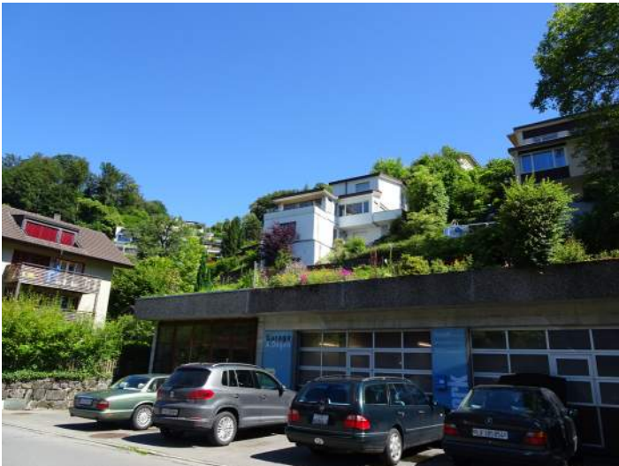
Abbildung 14: MFH mit Flachdächer in der Dormenstrasse (Hintergrund)
