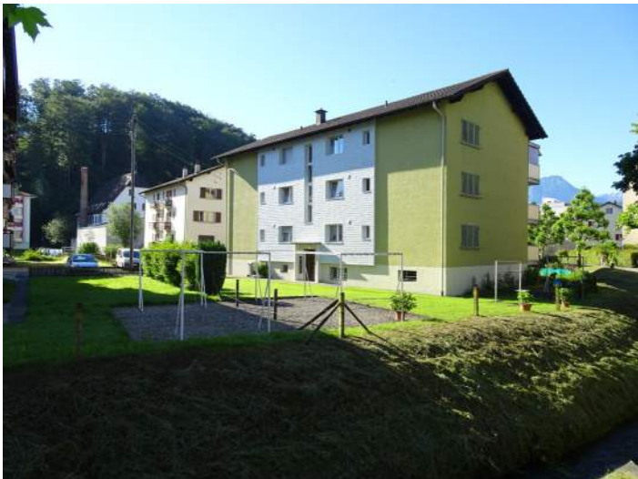
Abbildung 10: Zeilenbauten in der Riedmattstrasse, wenig kleine Fenster, im EG kein Zugang zu Aussensitzplätze
