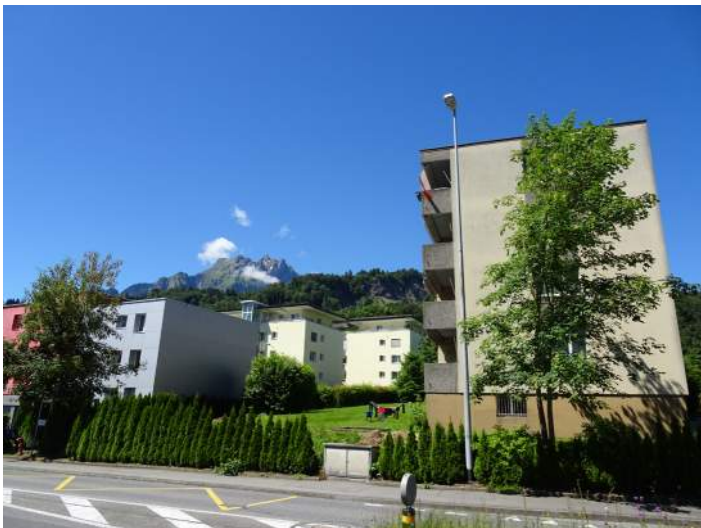
Abbildung 16: von der Technikumstrasse aus, im Hintergrund bereits sanierte Gebäude
