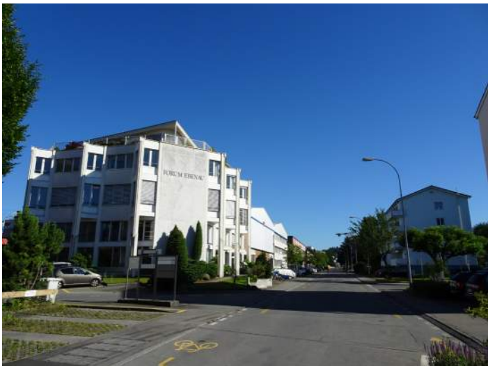
Abbildung 20: Blick von der Ebenastrasse Richtung Norden, links Gewerbegebiet Äbenau, rechts Riedmatt Quartier (2).
