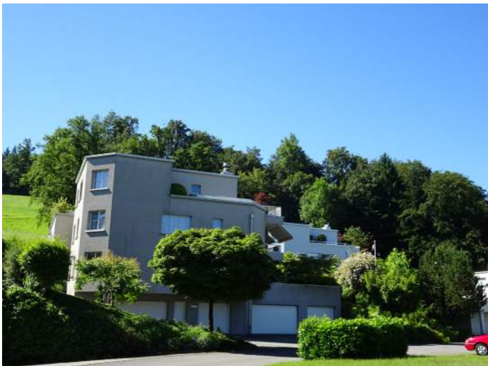
Abbildung 8: typische Bebauung in der Neumattstrasse, gute Qualität der Grün- und Freiräume
