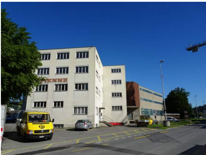
Abbildung 25: Gewerbegebäude an der Ebenastrasse
