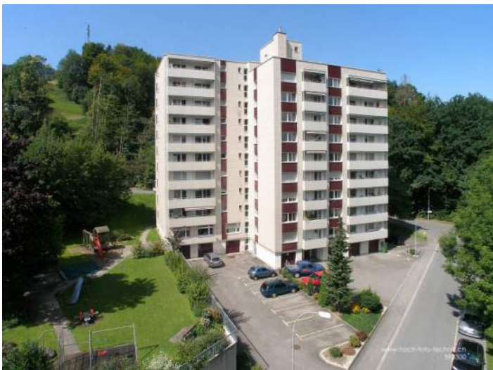
Abbildung 23: 9 geschossiges MFH in der Spitzberglstrasse, grosse Fläche versiegelt (Quelle: hoch-foto-technik.ch)
