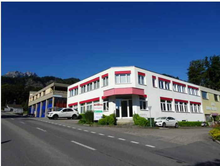
Abbildung 26: Gewerbegebäude an der Schlundmatt
