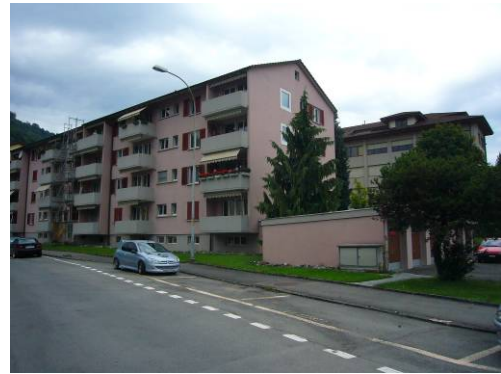
Abbildung 29: li. Wohnhäuser nördl. Altsagenring, re. Wohnhäuser südl. Altsagenring
