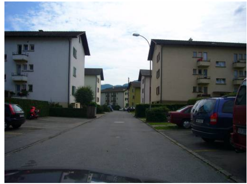
Abbildung 17: li. Neubauten südliche Riedmattstrasse, re. südliche Riedmattstrasse
