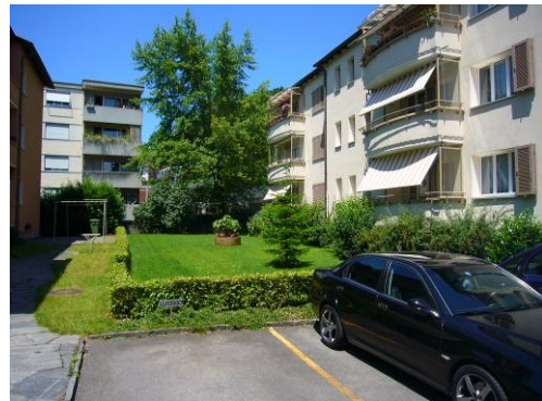
Abbildung 12: li Blick von der Kantonstrasse., re Vorbereiche/Freiräume
