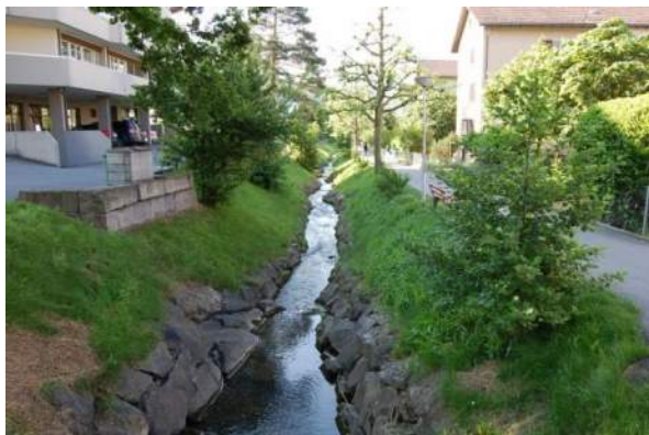
Abb. 3: Unterhalb Krienserstrasse. Das Gerinne ist hier etwas steiler, die Ufer massiv mit Blöcken verbaut.
