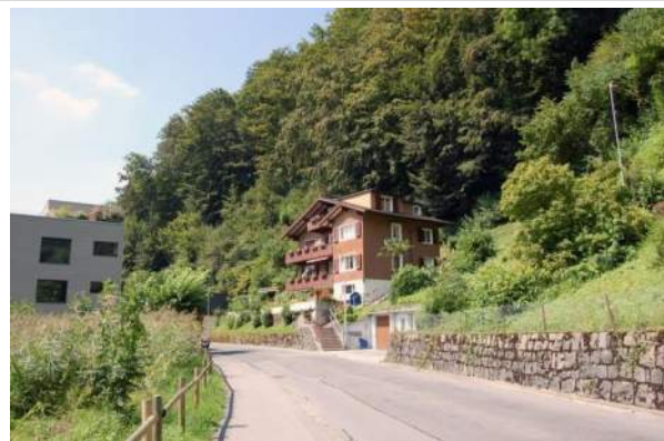
Abb. 32: Rank: fehlende/mangelhafte Durchgängigkeit zwischen Steinibachried und Herrenwald. Das Schutzkonzept Steinibachried von 1995 sieht Quervernetzungsmaßnahmen rechts im Bild vor.
