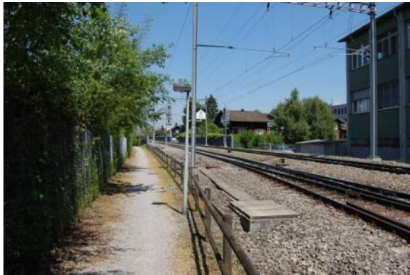
Abb. 59: Bahnlinie im Gebiet Wegmatt.
