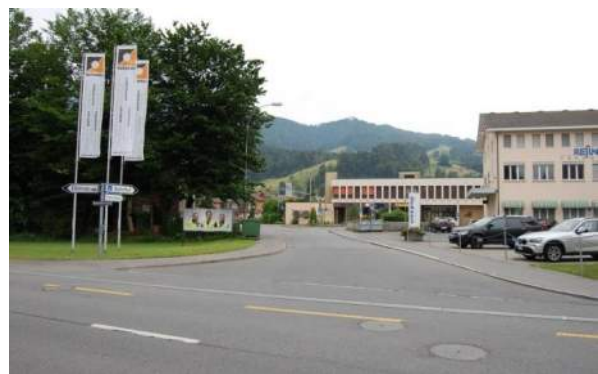
Abb. 68: Blick von der Ebenastrasse in Richtung Bahnhof.
