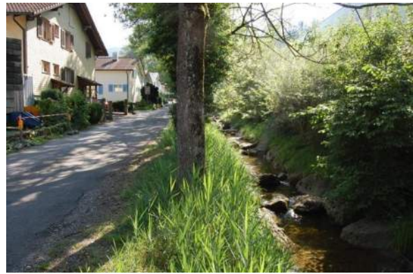
Abb. 24: Steinibachweg unten, vor Werkhof.
