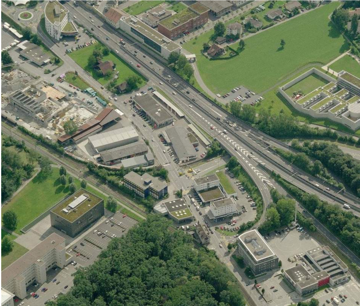
Abb. 88: Strassenverkehrsamt bis Kreisel Nidfeldstrasse
