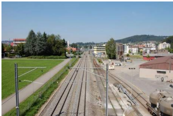
Abb. 61: Blick von der Brücke Kantonsstrasse gegen Norden.
