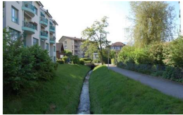
Abb. 2: Oberhalb Durchlass/Eindolung Krienserstrasse.
