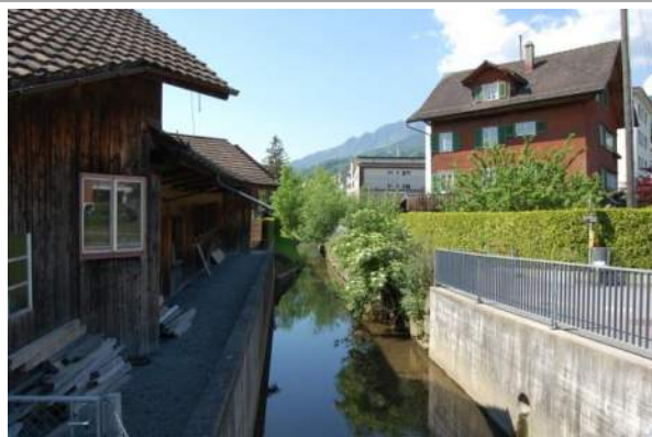
Abb. 13: Auslauf Durchlass Ringstrasse
