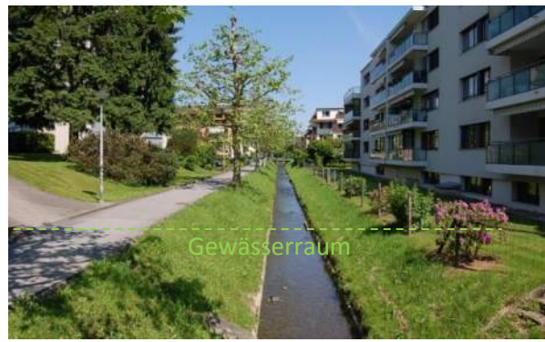
Abb. 18: Blick bachaufwärts ab der Kantonsstrasse;
