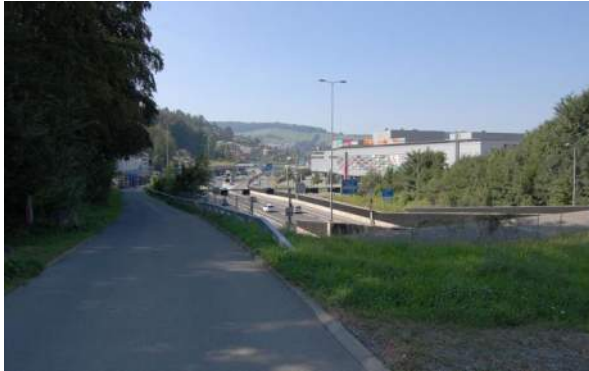
Abb. 74: Anfang/Ende der Achse, Tunnelportal Nord
