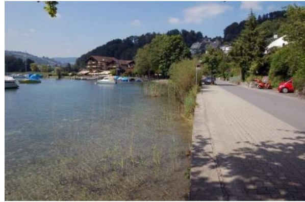
Abb. 30: Die Seestrasse reicht bis ans Wasser. Das Ufer ist hart verbaut. Es fehlt ein vorgelagerter, naturnaher Uferbereich, der die Längsvernetzung für Kleintiere ermöglicht.
