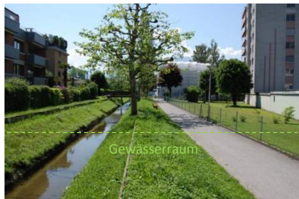
Abb. 20: streng trapezförmiges Gerinneprofil. Die Böschungen wurden offenbar nachträglich (dammartig) erhöht.
